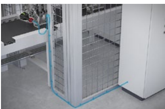
Kein Zeitverlust aufgrund der Verkabelung
